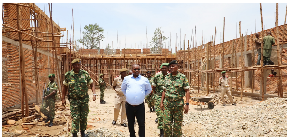
Les travaux de construction de la pharmacie à la BLFDNB vont bon train
